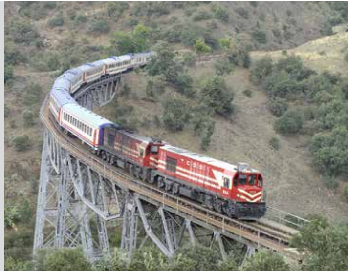
Bandırma-Izmir Demiryolu Hattı
